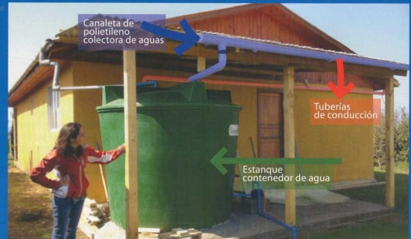
La cosecha de aguas lluvias, es una técnica que permite capturar o desviar el agua caída de la precipitación de un área determinada, para ser utilizada en el riego de cultivos, como huertas familiares. La estrategia incluye la utilización de los techos de las casas y otras construcciones, para captar y conducir el agua, acumulándola en estanques de 5.400 litros. El sistema se compone de tres partes:
